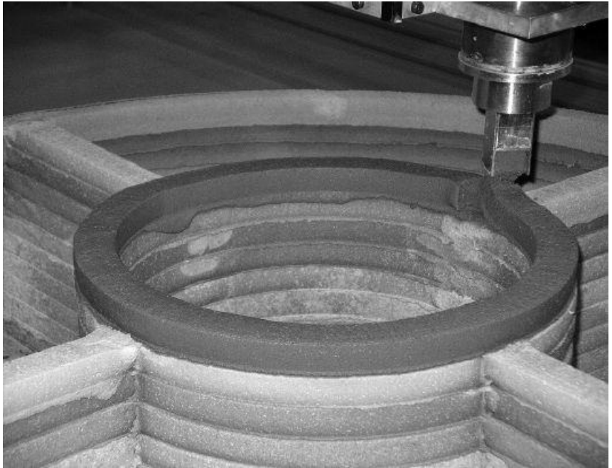
图10-9 轮廓工艺从喷嘴中喷射纤维增加水泥强度
